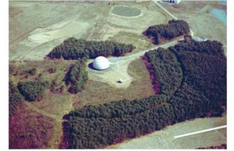
図1 磁気試験設備全景。
